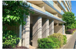
敷地の内外に緑が配されています
